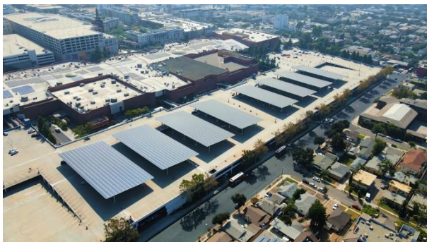
Két megoldás parkoló járművek árnyékolására napelemekkel
