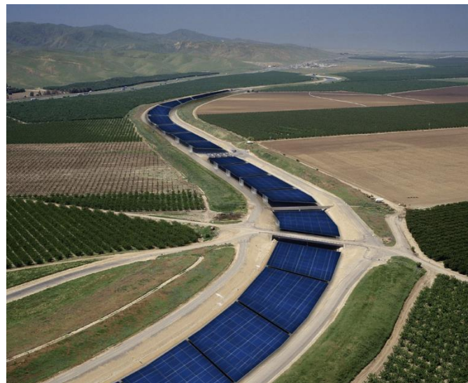
Csatorna fölött elhelyezett napelemek
